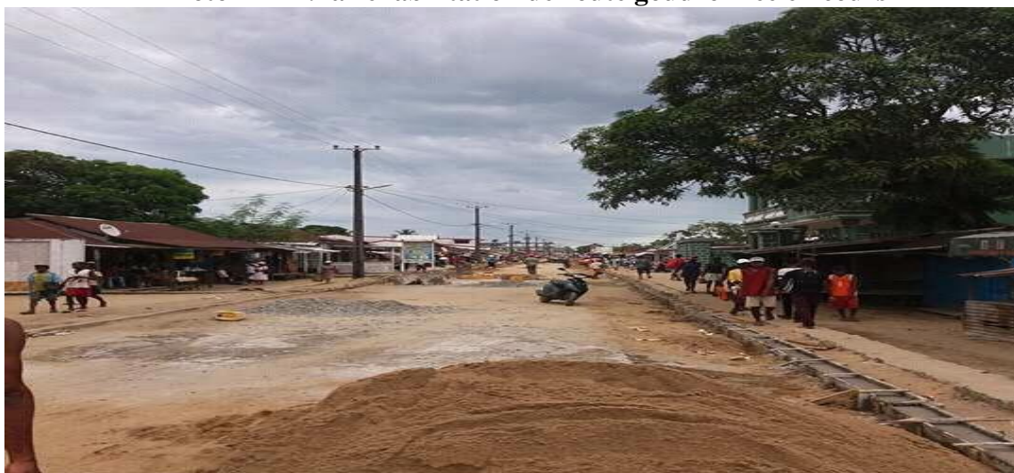
Photo n° 27 : la réhabilitation de route goudronnée en cours
